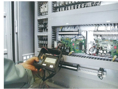
導通／通電検査作業
