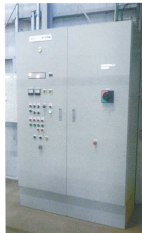
金属(アモルファス)再生プラント用 制御盤・・・プロテリアル
