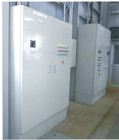
金属(アモルファス)再生プラント用 制御盤・・・プロテリアル
